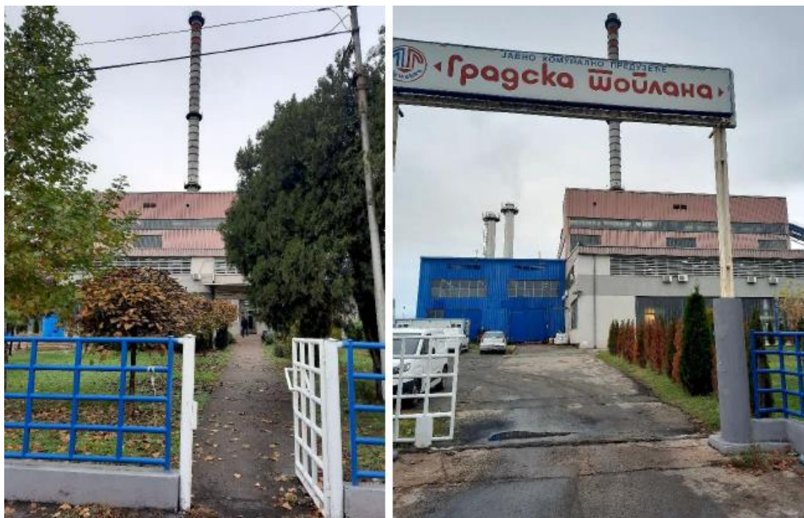
Слика бр. 4: Приказ постојећих објеката у комплексу ЈКП „Градска топлана Крушевац” – управна зграда и постојећа гасна котларница
