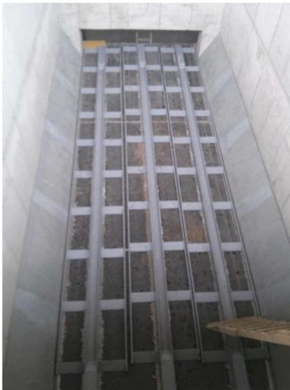
Слика бр. 18: Под складишта са покретним кровом
