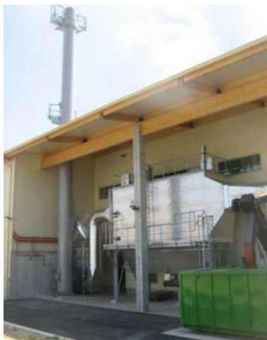
Слика бр. 21: Електрофилтер
