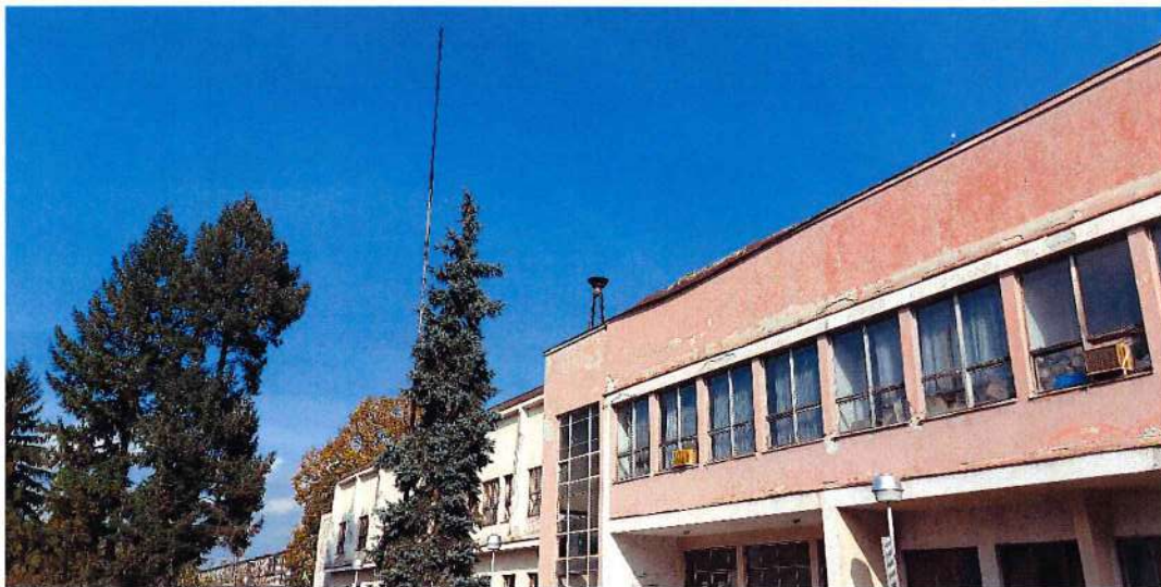
Слика 4.2-1. Кров управне зграде 14. Октобар на коме је инсталирана електрична алармна сирена КШ-5.
